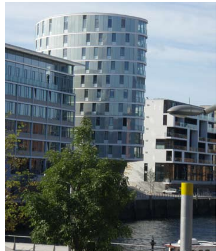
Nya och moderna byggnader i hamnområdet.
